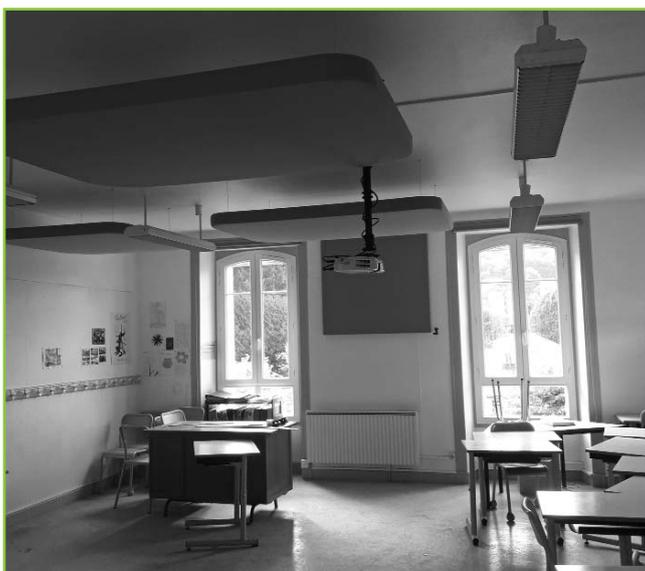
Des coussins acoustiques suspendus et des panneaux muraux ont été posés par les agents municipaux dans la classe des CM1-CM2 afin de limiter la résonance et de baisser le niveau sonore de la pièce. Le coût de ces matériaux s'élève à 5 160 € T.T.C.
